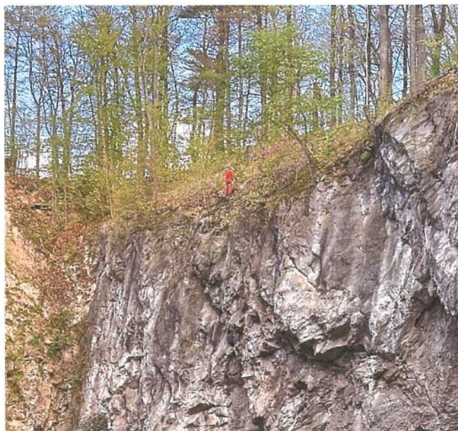
Obrázek č. 9 Lukeš odstraňuje uvolněné kameny a kusy dřevin v prostoru na spodní plošinou u Jezírka
