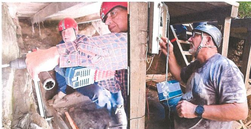
Obrázek č. 19 Lukáš, Ježek při instalaci kotev
