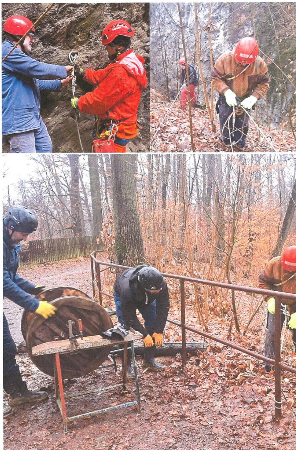
Obrázek č. 3, 4 a 5 instalace nového ocelového lana.
