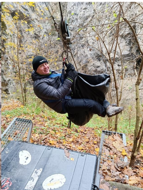
Obrázek č. 17 – D. Čani při kontrole vodícího lana lanovky
