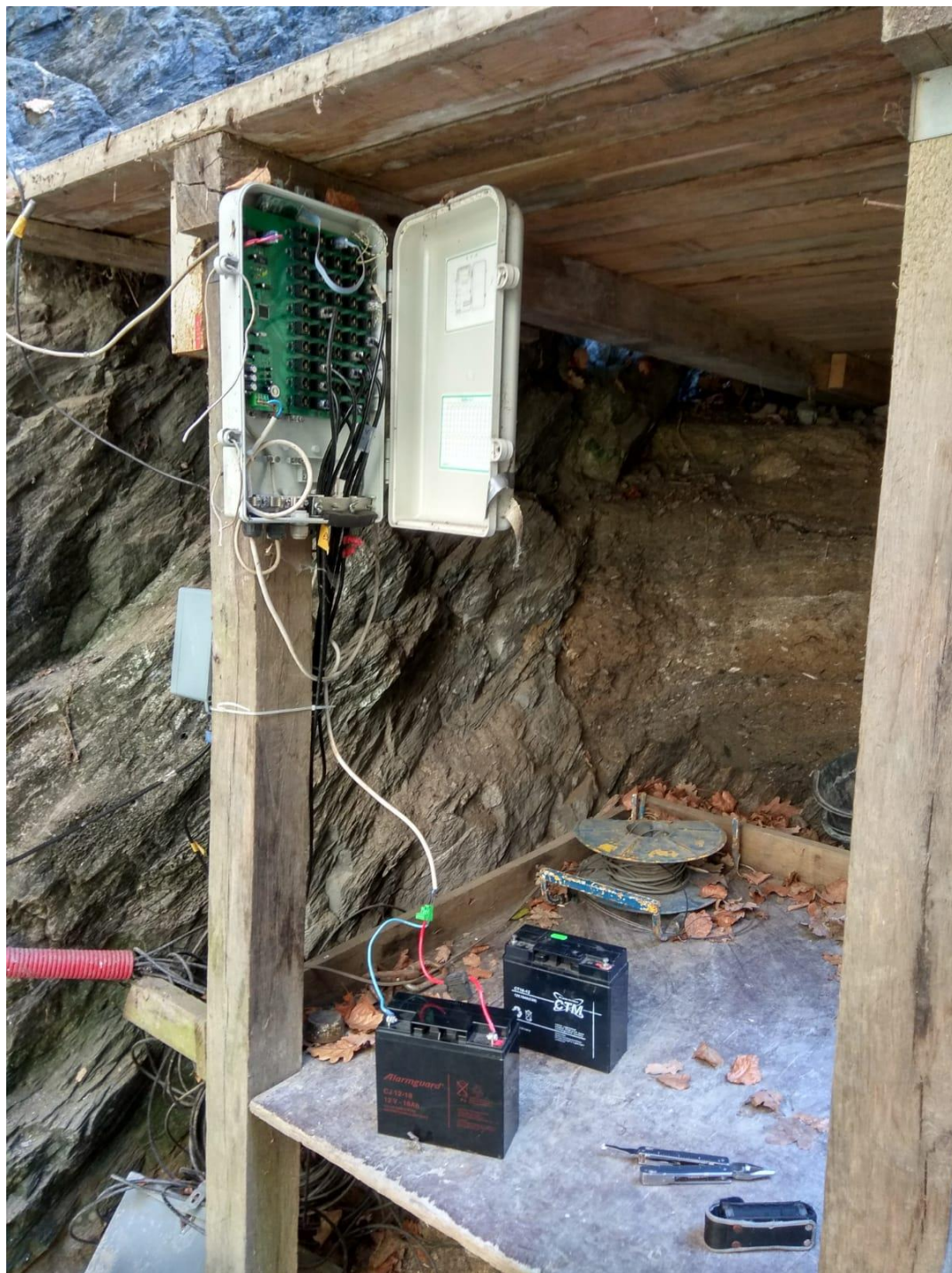
Výměna baterie v ústředně na plošině u Jezírka.
