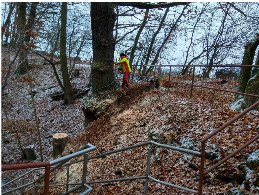
Pracovník fy. ARBOTYL s.r.o. při provádění odstranění předem určených stromů v prostoru nad vyhlídkovou plošinou.
