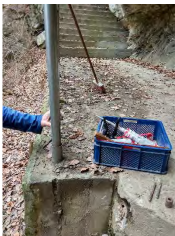
Kotvící body nosné konstrukce lana.
