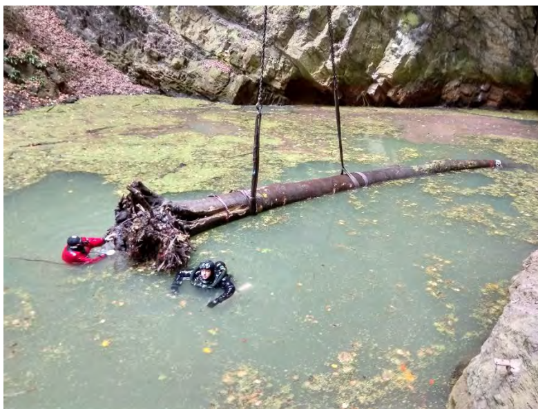
Uvázaný kmen buku za pomoci vázacích popruhů a řetězu na hák jeřábu, provedli potápěči z leva Martin Strnad a Viktor Krmelín.
