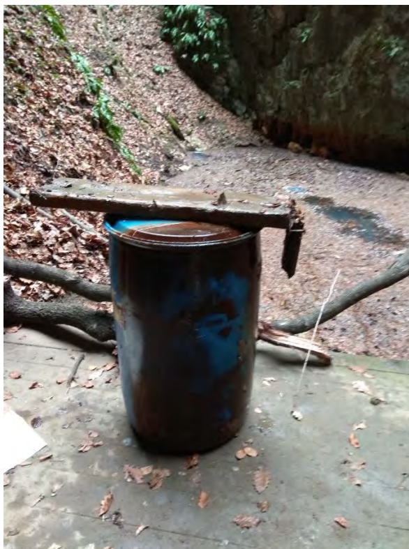
Poškozené uchycení barelu.
