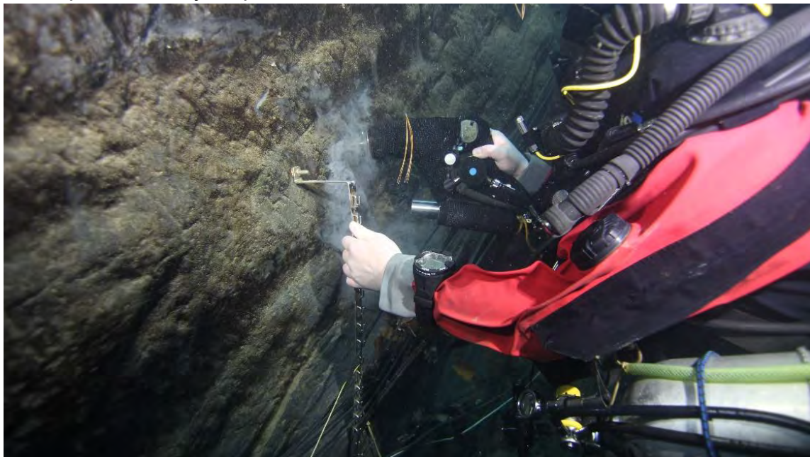
Miroslav Lukáš st. při instalaci kotevního bodu za pomoci podvodní vrtačky LOLA.
