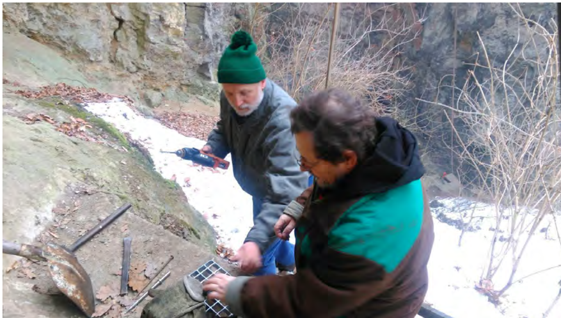
Tomáš Ježek se Zdeňkem Hoferkem při instalaci kovových nášlapů na plošinu u vrátku.
