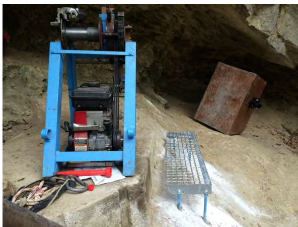
Instalace nového schodu na plošině vrátku.
